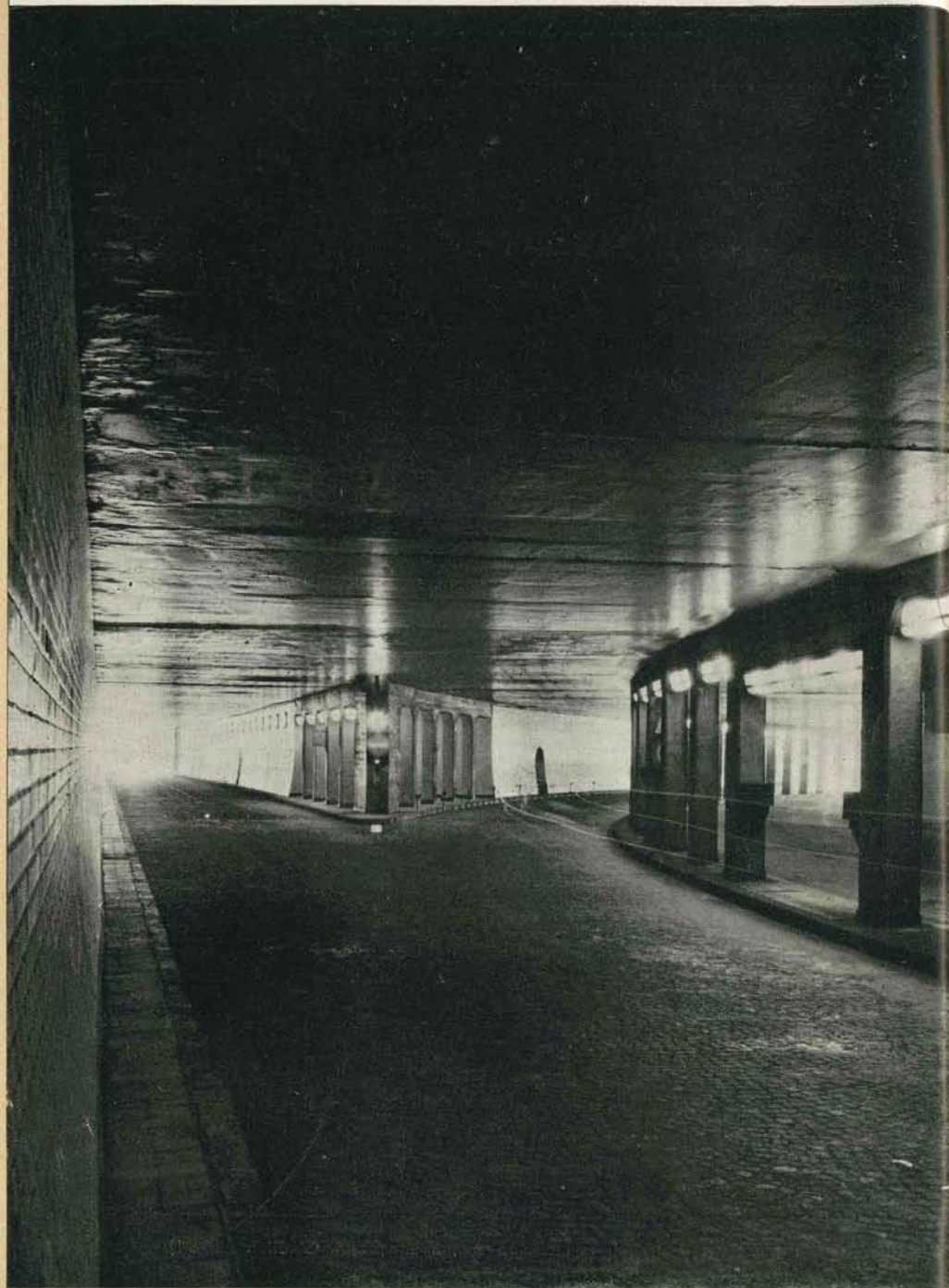
Paris. — Autoroute souterraine de la Porte Champerret
