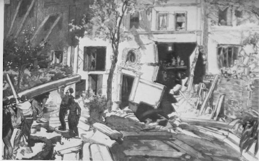
L'effondrement du passage Gourdon. Les anciennes carrières se rappellent au bon souvenir des Parisiens.
