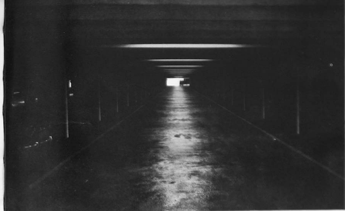
Le premier grand parking souterrain de Paris sous l'Esplanade des Invalides.
