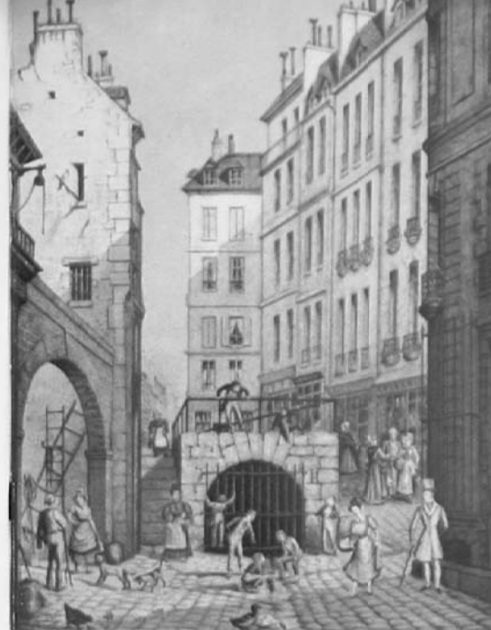
L'histoire de la technique des égouts parisiens est dans ces trois images; un égout à ciel ouvert a été recouvert, un égout axial le ruisseau est au milieu de la rue, le type d'égout imaginé par Belgrand.
