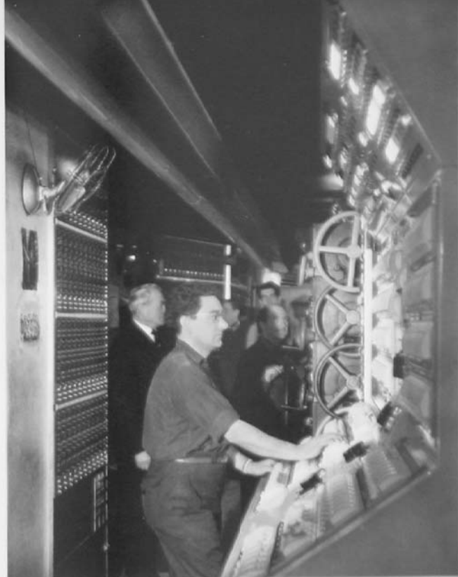
Enterré sous la scène de l'Opéra, l'énorme jeu d'orgue qui permet de régler tous les éclairages du plateau.
